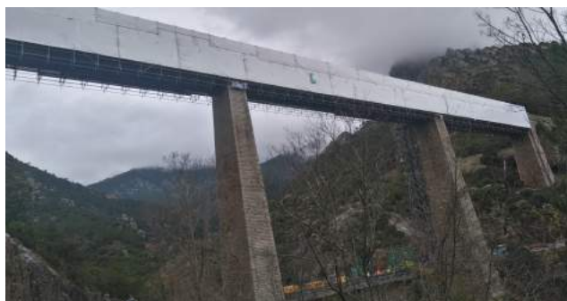
Pont ferroviaire du Vecchio
